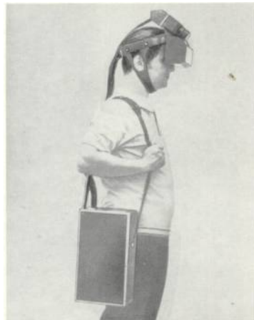
Figura 17. “Elektroftalm”, el dispositivo que permite a los invidentes “ver” a través de la unión del cerebro con la cámara con el uso del sentido del tacto /1/
